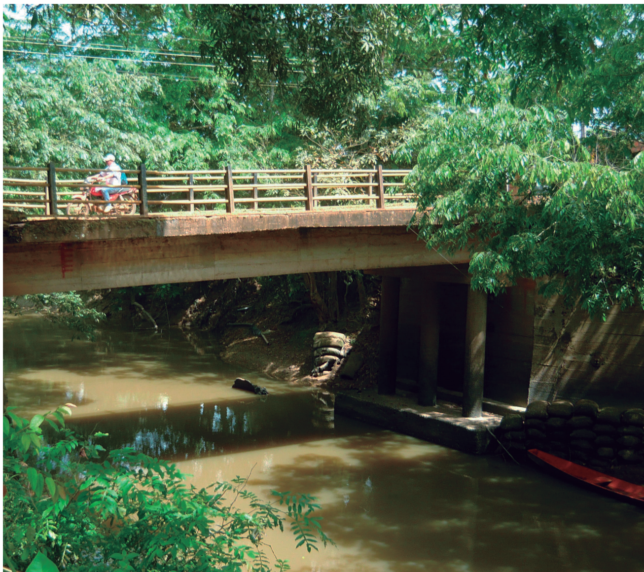
Figura 4. Puente de Caño Grande.
